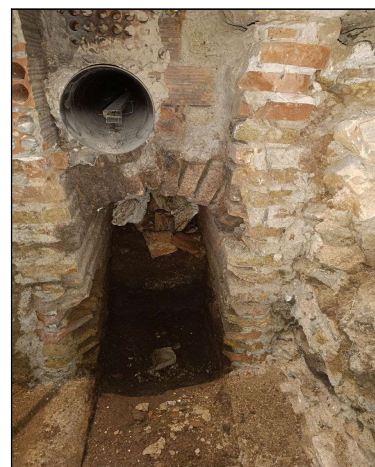
Fotografías 5,6 y 7: excavación existente en la parcela objeto de estudio en la zona del ascensor donde se observan materiales de relleno y estructuras de un antiguo canal.
