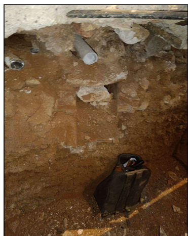
Fotografías 5,6 y 7: excavación existente en la parcela objeto de estudio en la zona del ascensor donde se observan materiales de relleno y estructuras de un antiguo canal.
